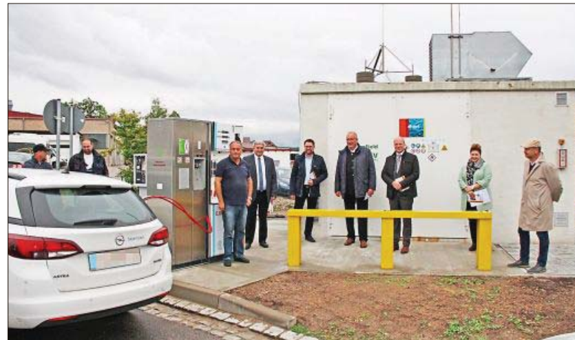
Eine Tankstelle für Biogas haben Mandatsträger und die E.ON Gas Mobil GmbH am Freitag in Roding eröffnet.
