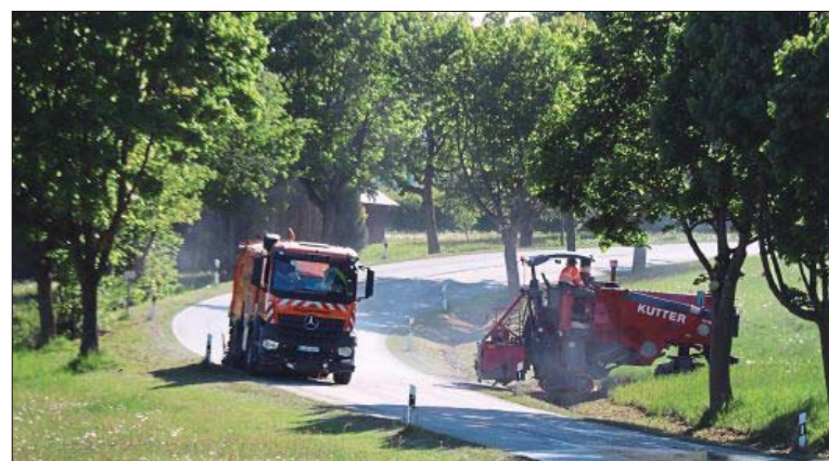
Im ersten Teil des zweiten Bauabschnitts wurde die Griffigkeit der Fahrbahn durch Ketten-schlagfräsen erhöht.
