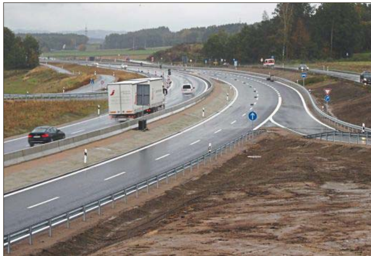
Nur vier Jahre nach dem Planfeststellungsbeschluss ist das erste Teilstück der B85 zwischen Piending und Altenkreith fertiggestellt. Ab Dienstag fließt der Verkehr auf den neuen Fahrstreifen.
