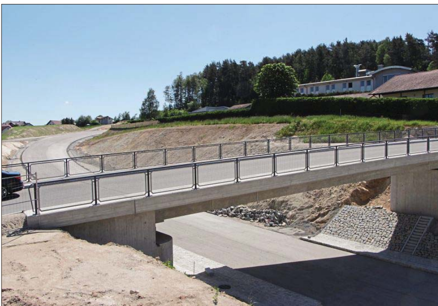
Die hydraulisch gebundene Tragschicht ist so gut wie fertig. Nächste Woche rückt die Teerkolonnen an, um in zwei Arbeitsgängen die Asphalt-Tragschicht aufzubringen.
