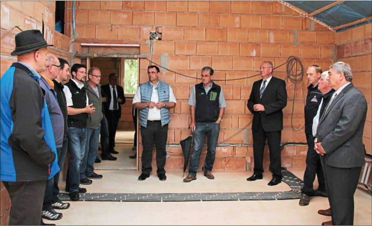
Im Beisein der Führung der FFW Engelshütt sowie der drei Bürgermeister machten sich Landrat Franz Löffler und MdB Karl Holmeier ein Bild vom Stand der Bauarbeiten im Feuerwehrgerätehaus Engelshütt. Foto: Fischer-Stahl
