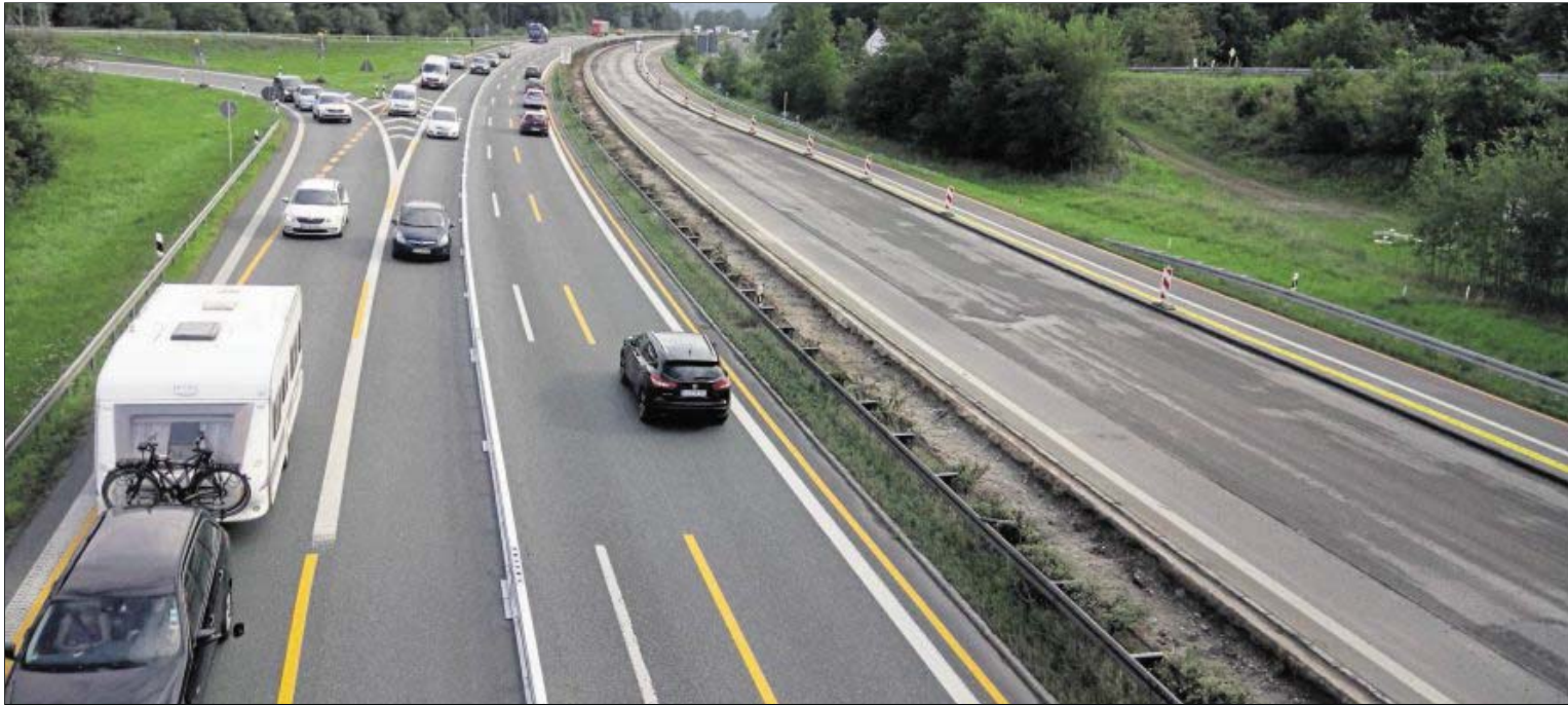
Die aktuelle Deckenerneuerung auf der Autobahn A 93 zwischen den Anschlussstellen Schwarzenfeld und Schwandorf-Nord ist wegen Schäden an der über 45 Jahre alten Gussasphaltdecke notwendig. Die Deckschicht wird durch einen modernen, lärntechnisch optimierten Splittmastixasphalt ersetzt. Ziel: Es soll leiser werden. Bilder: Dobler (2)
