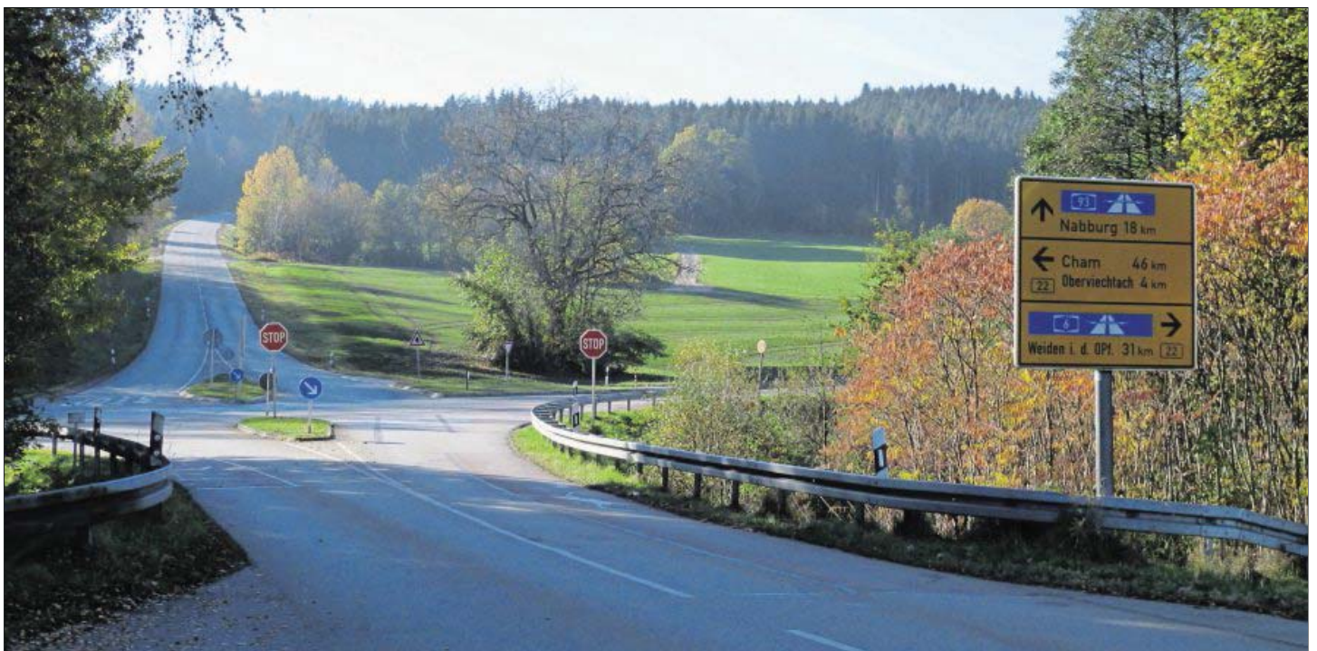
An der „Teunzer Kreuzung“ treffen die Bundesstraße 22 (Ostmarkstraße), die Staatsstraße 2156 und die Kreisstraße SAD 42 aufeinander. Diese Vollkreuzung wird es künftig nicht mehr geben. Mit dem Umbau soll der Unfallschwerpunkt entschärft werden. Bilder: Portner (3)
